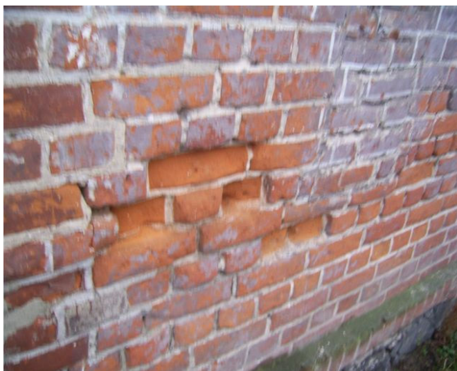
Zawilgocenie ścian stało się przyczyną degradacji cegły
