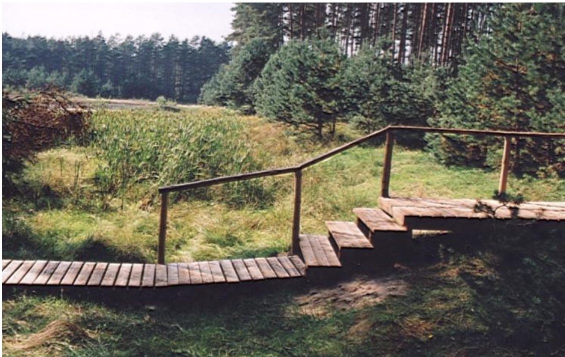
Ryc. 7. Widok kładki drewnianej (zejście ze schodami)
